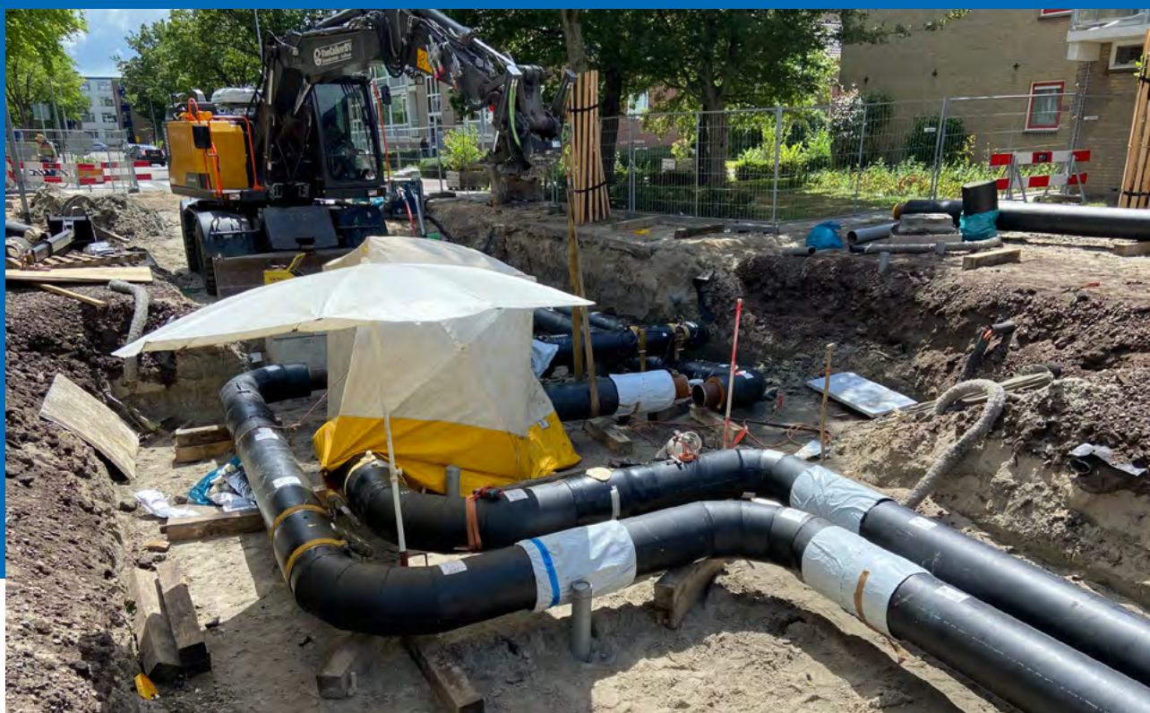
Aanleg van het warmtenet in Selwert
