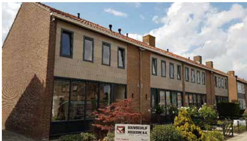
Figuur 12. Gevel met vlas-isolatie en vlascomposiet panelen. Foto NPSP.
