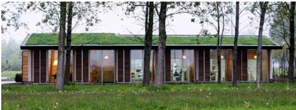
Figuur 16. Tandartspraktijk op basis van Lariks spanten, houtvezelisolatie en sedum dak. Foto ORGA architect.
