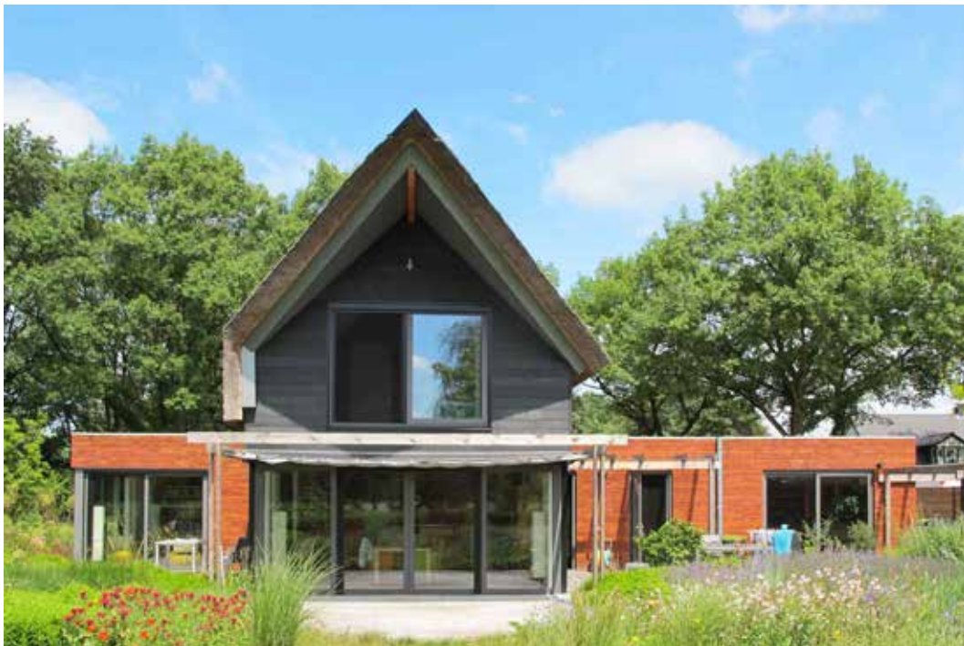
Figuur 15. Houtskeletbouw woning met isolatie van schapenwol, riet- en sedumdak (inzet beneden) en een zonneboiler (inzet boven). Foto ARCHES architecten BNA.
