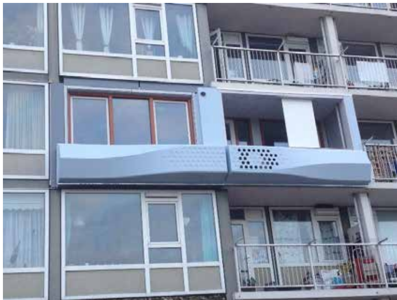
Figuur 14. Gevel van vlasvezelcomposiet panelen met daarin een lucht-warmtepomp. Foto NPSP.
