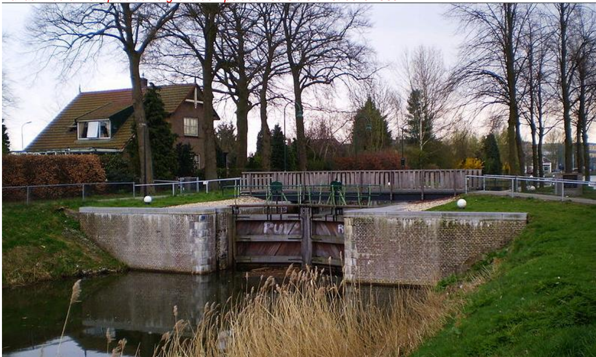
Een recente opname van de Apeldoornse Sluis met sluiswachterswoning. De gemetselde sluis kom verving in 1884 een oudere houten kom. Bron: Wikipedia/Apeldoornsesluis
