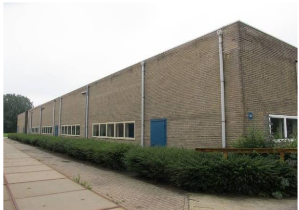
Noordgevel aerosolfabriek (gebouw 50)
