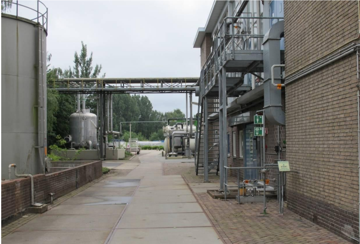
Zicht door de langs het kanaal verlopende as richting zuiden met rechts het extractiegebouw (hal 3) van de oude alkaloidenfabriek en links de ketel voor stookolie en op de achtergrond, ketels en leidingen voor transport en opslag vangrond- en brandstoffen. MAB 2011
