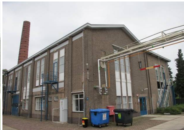
Het oudere deel van het ketelhuis, oost- en noordgevel
