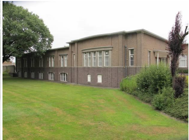
Gebouw 20-21 westgevel en zuidgevel.
