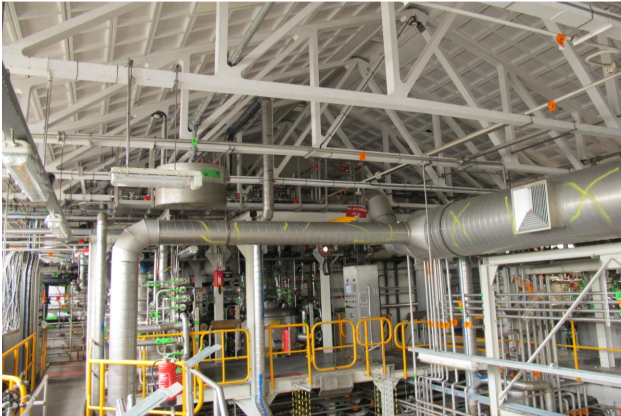
Ook de driebeukige hal is in de late 20 ste eeuw behoorlijk volgestouwd met tussenvloeren, trappen, installaties en en leidingen en buizen. Daarboven is nog wel de fraaie betonnen kap zichtbaar. MAB 2011
