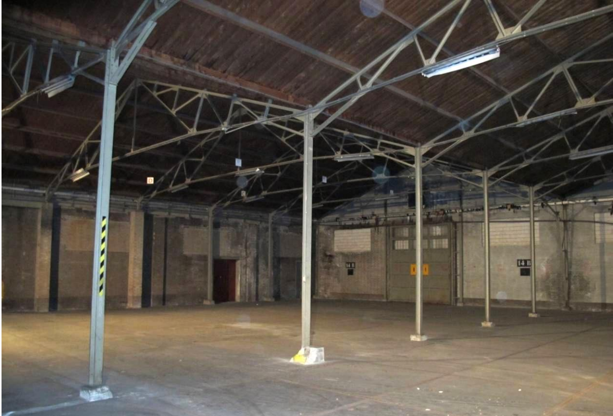
De staalconstructie met stalen kolommen (H-balken) en vakwerkspanten met daarop houten gordingen en beschoot van het zuidelijke deel van de dubbele kaffloosden uit 1951/52 die de brand van 1953 overleefden. MAB 2011
