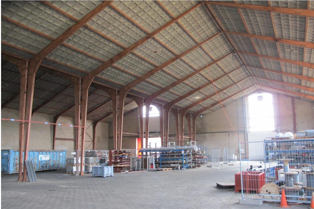
De imposante ruimtewerking van de drieslagkafloodsen (gebouw 47) met stalen kolommen met stalen sikkelspanten en gordingen met Bimsbeton cassettenplaten als dakplaat. MAB 2011
