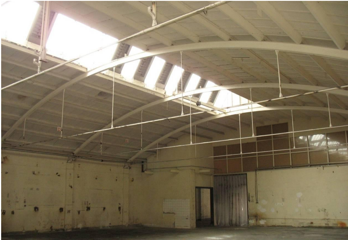
Eén van de twee grote beuken van de Zwitsalfabriek (gebouw 17) uit 1951/52 met stalen boogspanten met daarop houten gordingen en een sheddakvormige lichtstraat op de nok. MAB 2011
