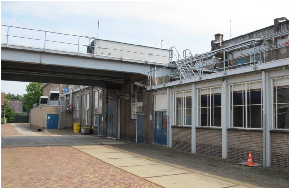
Zicht door de oude hoofdas richting oosten ter hoogte van de oude loopbrug met rechts de oude alkaloidenfabriek, waartegen later aan deze zijde tussen 1950 en 2000 allerlei aanbouwen zijn toegevoegd. MAB 2011
