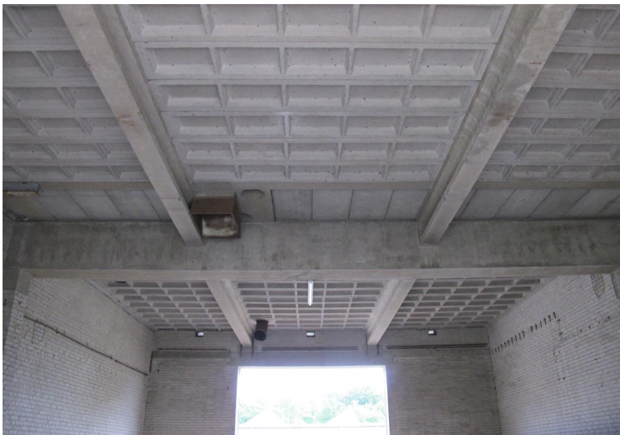
Het plafond van de doorgang (gebouw 9) met betonnen balken en Bimsbeton-cassettenplaten. De stook vlakken platen voor de balk bevindt zich ter hoogte van een ook in betonconstructie opgebouwde lichtstraat waar tevens pijpen werden doorgevoerd vanuit de naast gelegen maalderij en waardoor gemalen kaf in de verschillende ruimten kon worden gestort. MAB 2011
