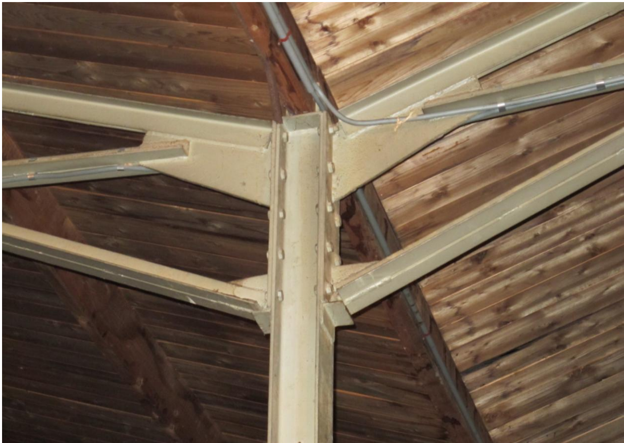
Detail van een kolom met de aanzet van twee vakwerkspanten in de oude kaffloodsen (gebouw 14b).
