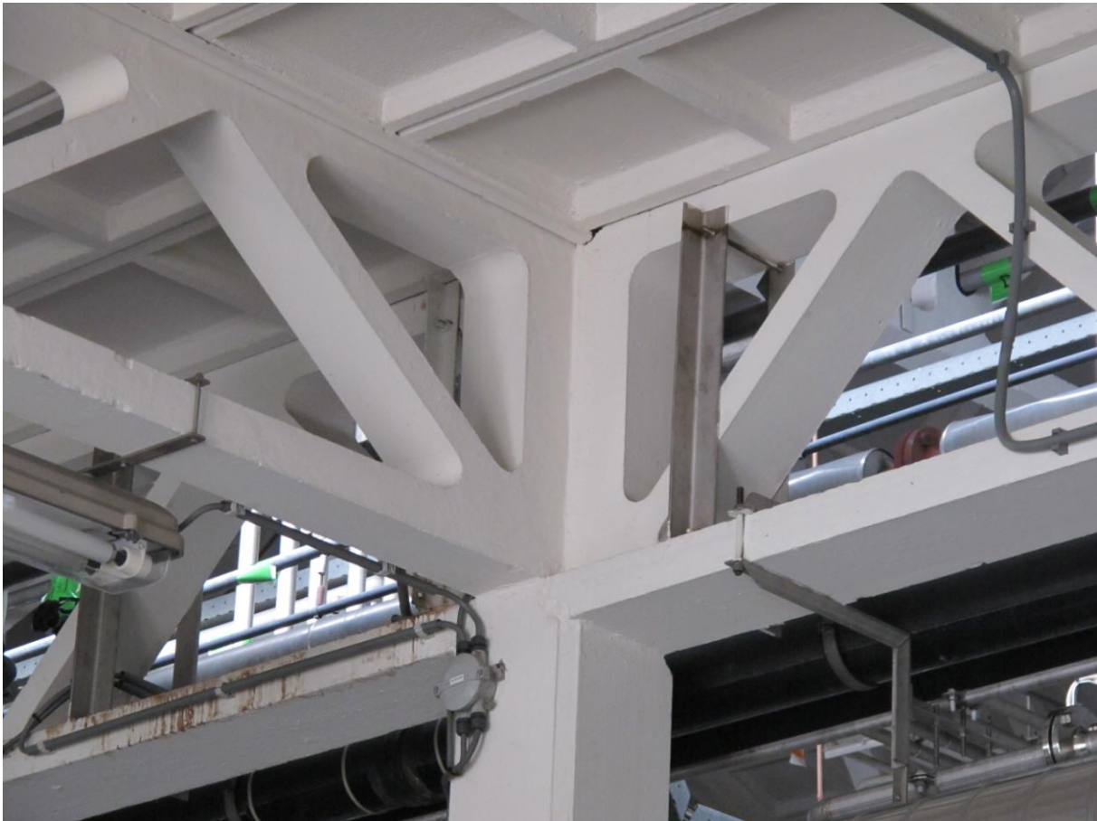
Een betonnen kolom met de oplegging van betonnen vakwerkliggers die de lichtbeuk dragen en haaks daarop de vakwerkligger van het platte dak van de zijbeuk (linksboven). MAB 2011
