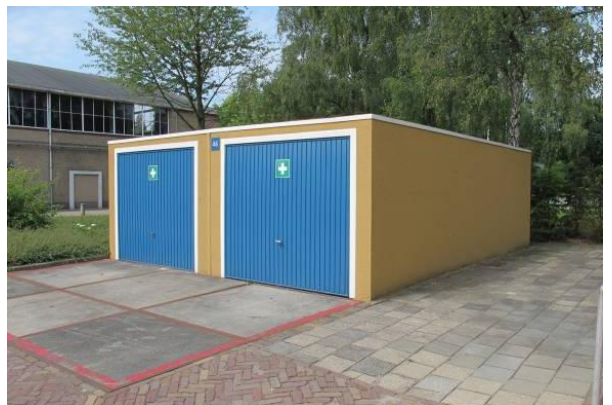
Oost- en noordgevel brandweergarages (gebouw 46)
