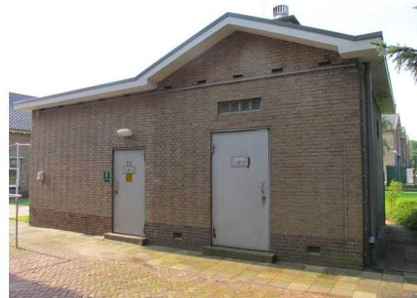
Gebouw 30 trafo met links jongere aanbouw
