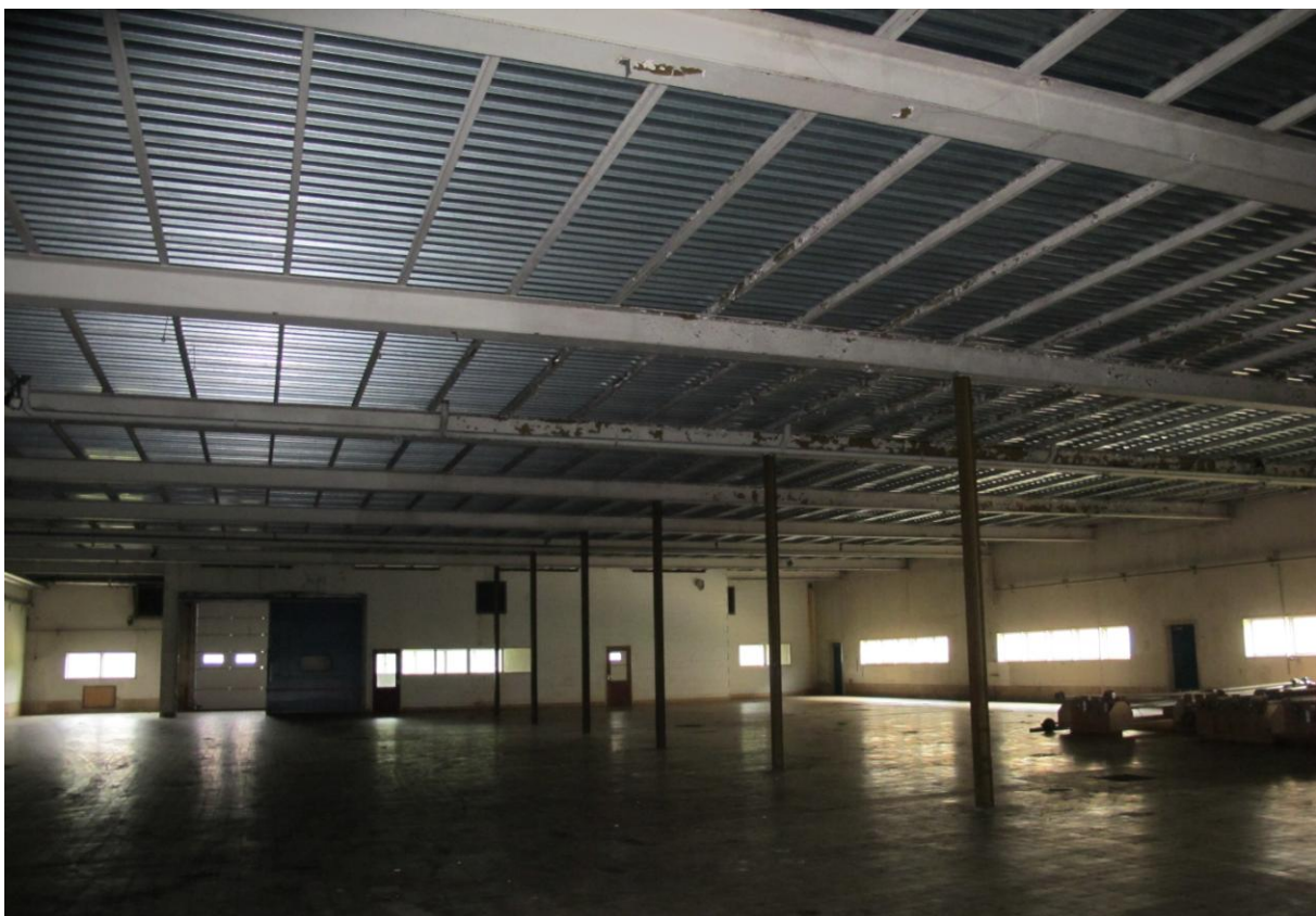
Interieur van één van de hallen van de Aerosolfabriek van 1969 (gebouw 56/57) met een vergelijkbare constructie met stalen kolommen, liggers en gordingen als die van gebouw 18. MAB 2011
