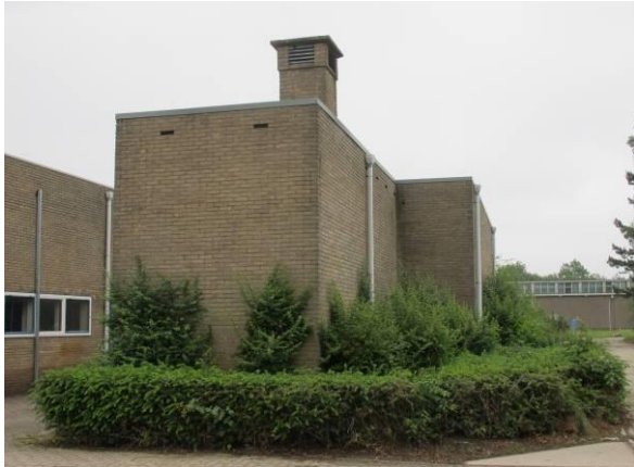
Gebouw 55, trafo bij aerosolfabriek vanuit westen
