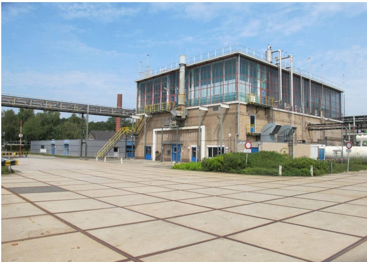
Het extractiegebouw (hal 4, gebouw 43) uit 1959 op "zuid" gezien vanuit het zuid-oosten met op de voorgrond het met Stelconplaten bestrate opslagterrein voor afvalstoffen. Let ook op de transportbanen die door de lucht naar het gebouw leiden MAB 2011
