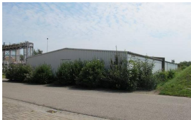
Jonge loods (gebouw 63) vanuit het westen
