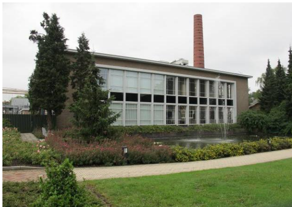
Het jongere deel van het ketelhuis, westgevel.
