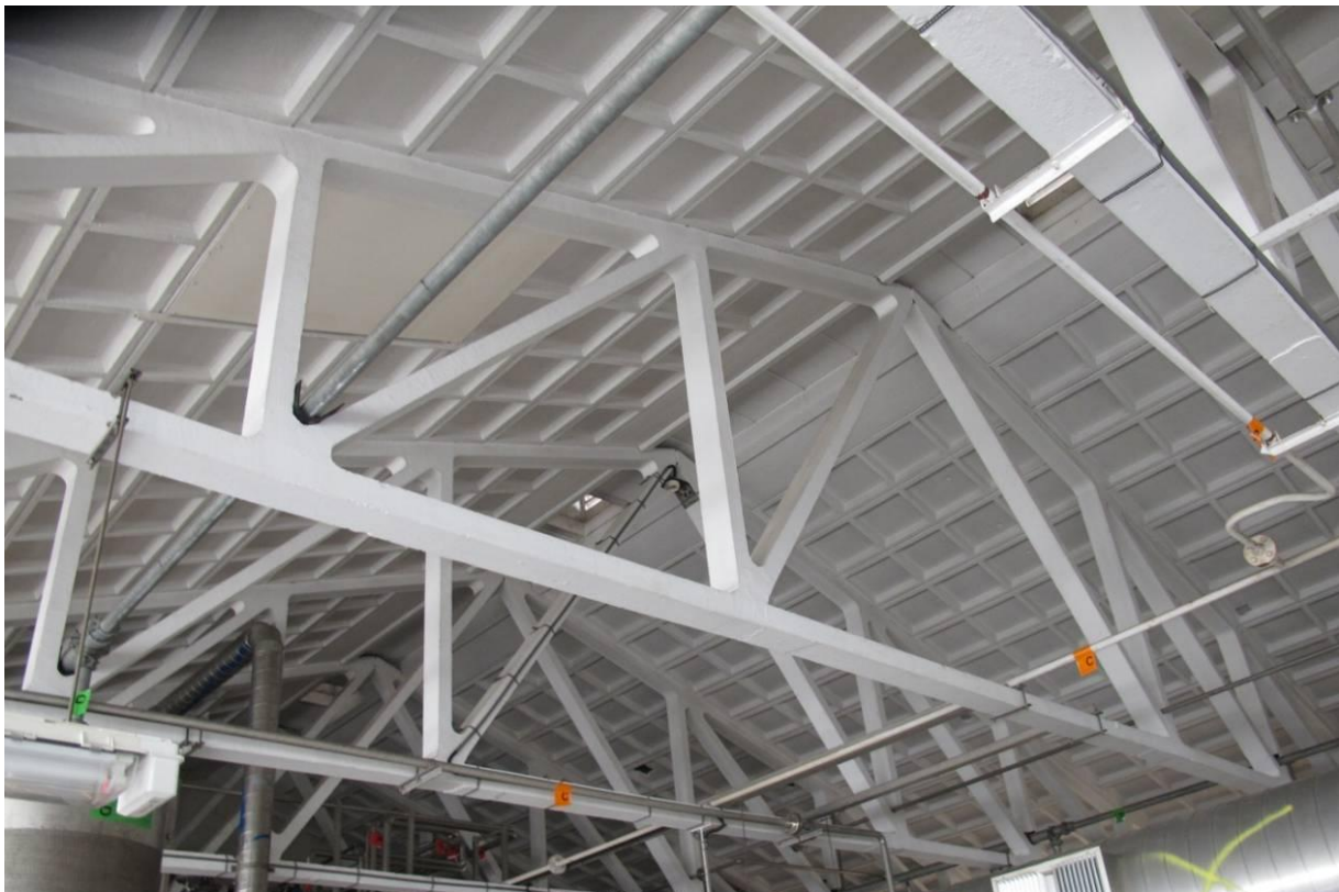
Zicht op de betonnen vakwerkspanten van NV Schokbeton in de kap boven de middenbeuk van het driebeukige gedeelte van de Alkaloïdenfabriek uit 1946/47. De dakvlakken bestaan uit bimsbeton-cassettenplaten Een dergelijke constructie kreeg ook het oudste deel van het ketelhuis, maar ook het jongere verpakkingsmagazijn (latere kantine, gebouw 24) uit 1959. MAB 2011
