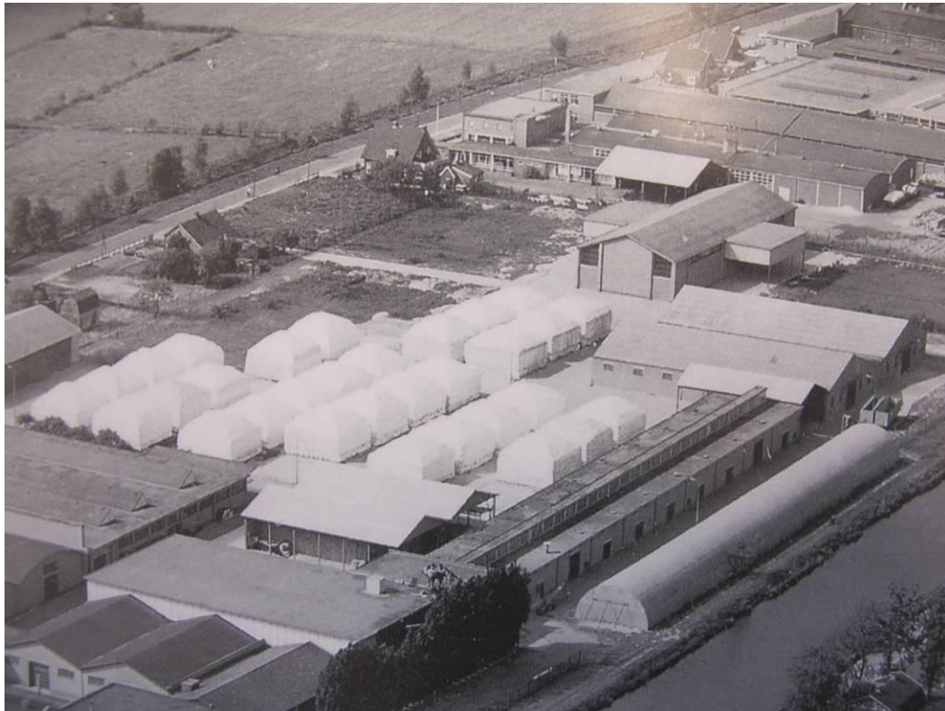
Uitvergroot gedeelte van de foto uit 1961 van het noordelijke deel van het terrein. Op het hier nog braakliggende terrein aan de zijde van de Vlijtseweg zouden in 1969/70 de gebouwen van de aerosol (Aerofako)fabriek gaan verrijzen, waarbij dus ook de nog overgebleven huizen aan de Vlijtseweg zouden verdwijnen.
