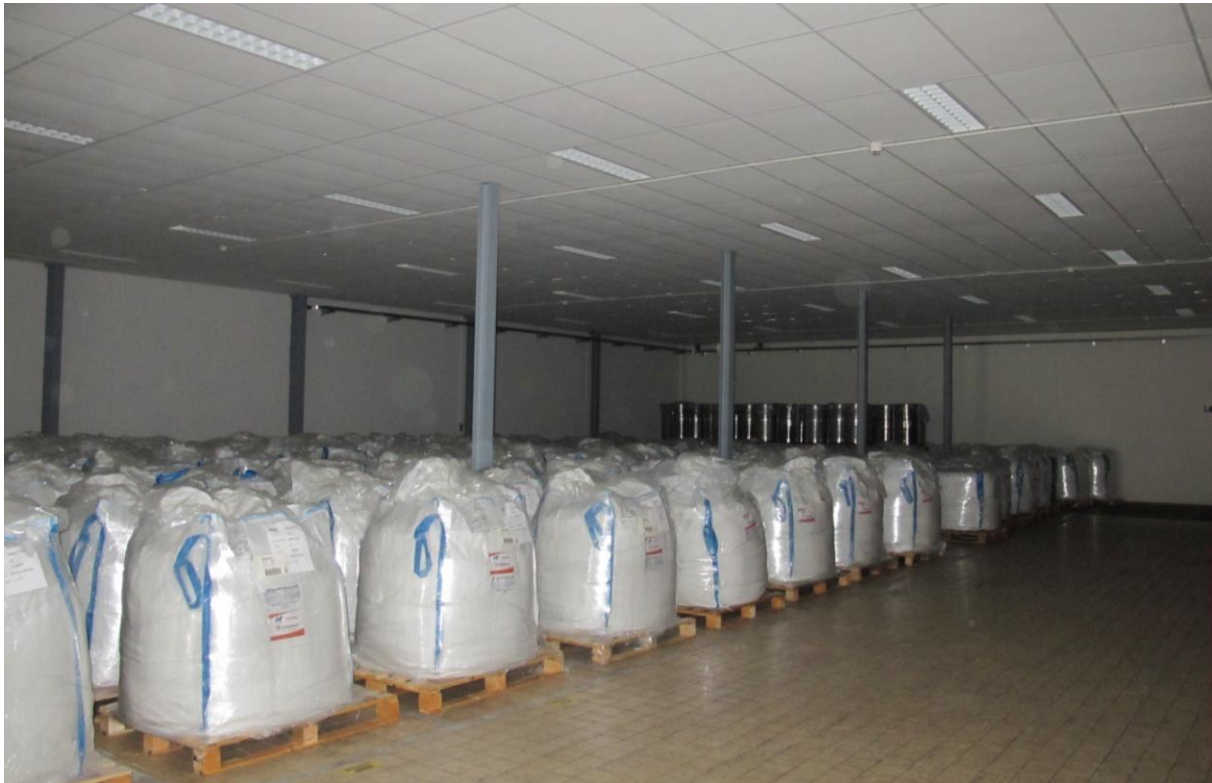
Interieur van het oude Aerofako-gebouw (gebouw 18) uit 1954, met een zeer sobere eenvoudige draagconstructie van stalen kolommen en stalen liggers, waarvan de toch al minder spectaculaire ruimtewerking en constructie door dichtzetting van de vensterstroken en het aanbrengen van een plafond (waarbij de lichtstraten niet meer zichtbaar zijn) sterk aan beleving heeft ingeboet. MAB 2011
