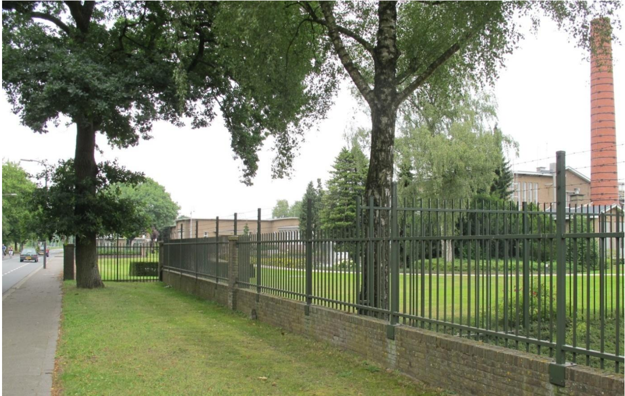
Zicht langs de hekwerken en tuinen langs de Vlijtseweg ter hoogte van het zuidelijke fabrieksterrein gezien in noordelijke richting. Rechts op de achtergrond het ketelhuis en de markante schoorsteen en links van het midden de kantoorgebouwen uit 1950 en 1951. MAB 2011
