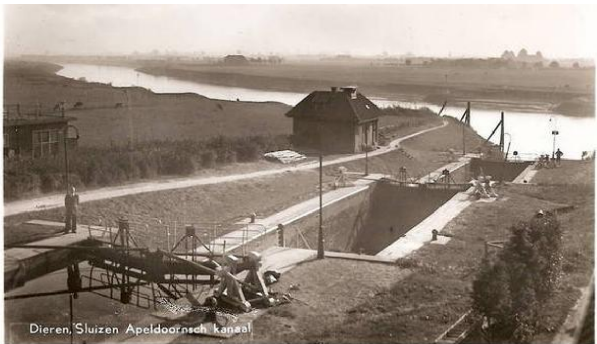
De bouw van de sluizen bij Dieren omstreeks 1865. Hier sloot het zuidelijke deel van het kanaal op de IJssel aan. Bron: Oudeansichten.nl
