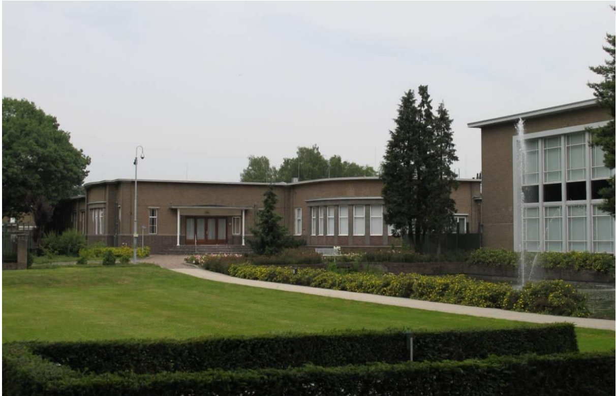
Zicht op de tuinen en vijver en de kantoorgebouwen (links en midden) en ketelhuis (rechts) bij de hoofdentree. MAB 2011.
