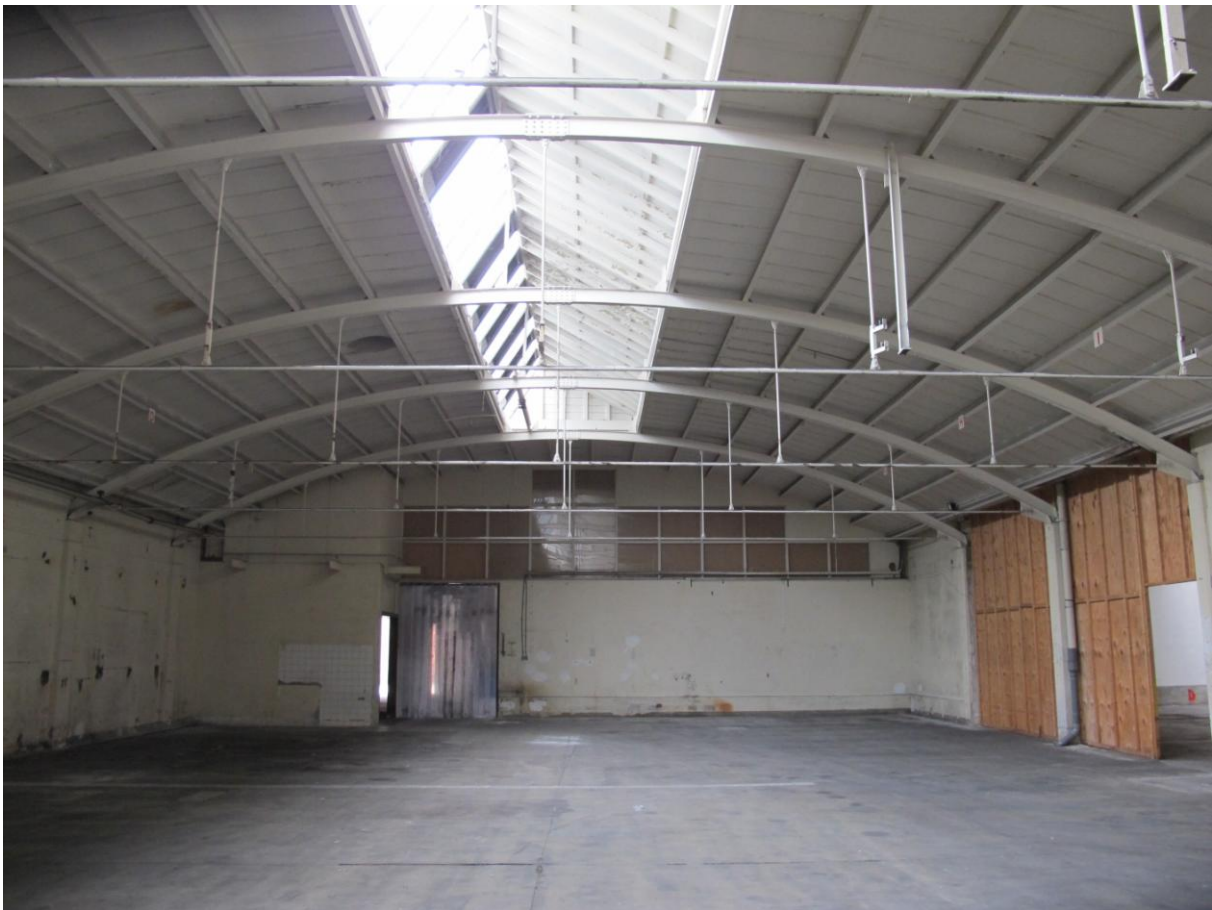
Zicht door één van de twee hallen van gebouw 17 met stalen boogspanten met trekstangen en drukstaven en op de spanten een houten gordingenkap. De sheddakvormige lichtstraat heeft een houten dak, stalen ramen en stalen schoortjes die op het boogspant rusten. MAB 2011
