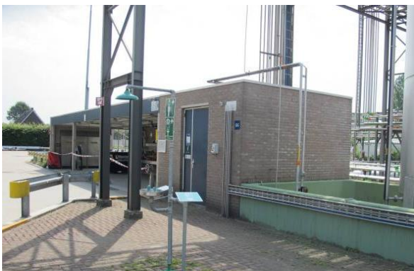
Kantoor en abri bij tankpark (gebouw 66)
