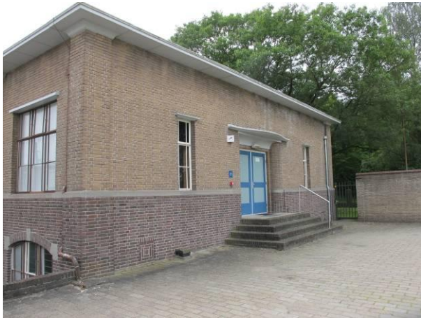
Gebouw 21, noordgevel en links de oostgevel.
