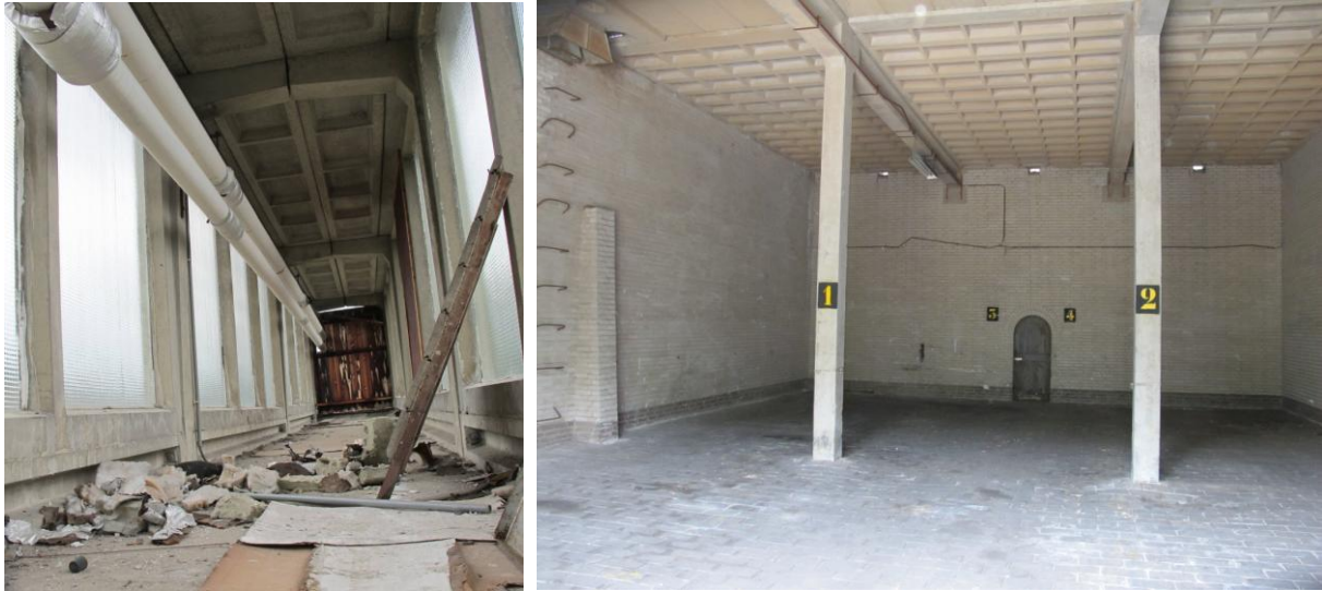
Zicht door de betonnen lichtstraat van gebouw 8 en 9 (links) en het interieur van één van ruimten van gebouw 8 met betonnen kolommen, balken en cassettenplaten (rechts). MAB 2011
