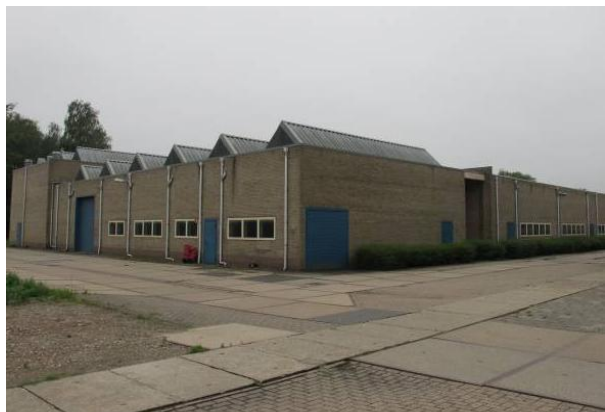
Aerosolfabriek, gebouw 50-54 vanuit noord-oosten
