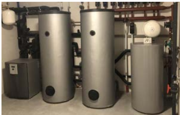
Figuur 1, voorbeeld opstelling in pandige buffervaten
