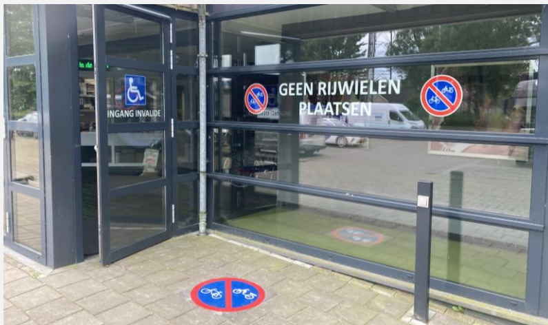
Afbeelding 1 Foto van de toegankelijk gemaakte ingang van Sporthal De Crosser in Werkendam. Bron: Gemeente Altena, 2024.
