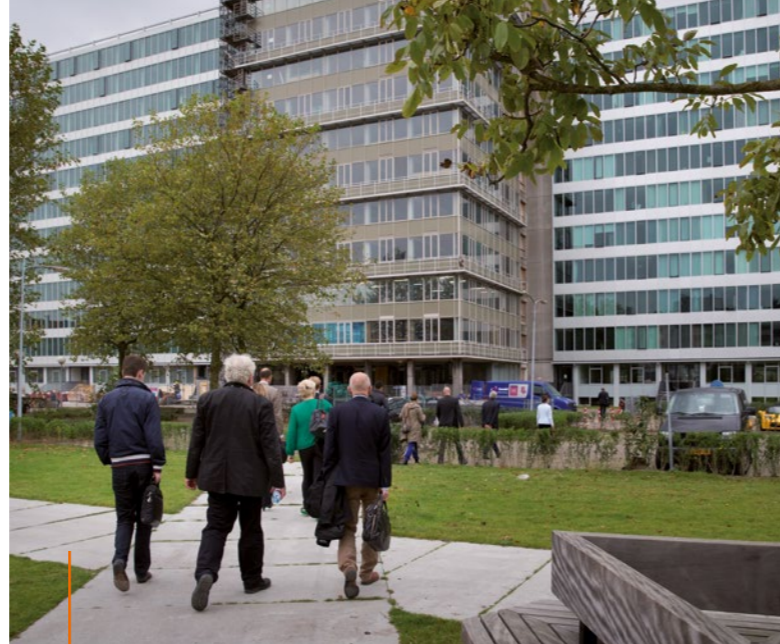
Noord-Holland • Door de transformatie heeft het voormalige GAK-kantoor in Amsterdam nu in totaal 651 appartementen, verdeeld over 11 woonlagen.
