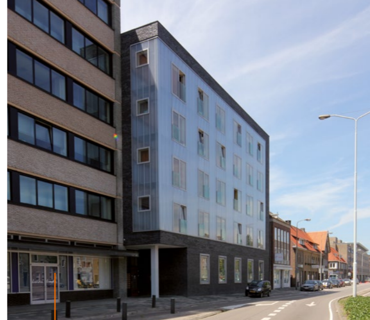
Noord-Brabant • Eindhoven bouwde al een aantal kantoren om tot woningen. In dit pand werden 46 zelfstandige studentenappartementen gerealiseerd.
