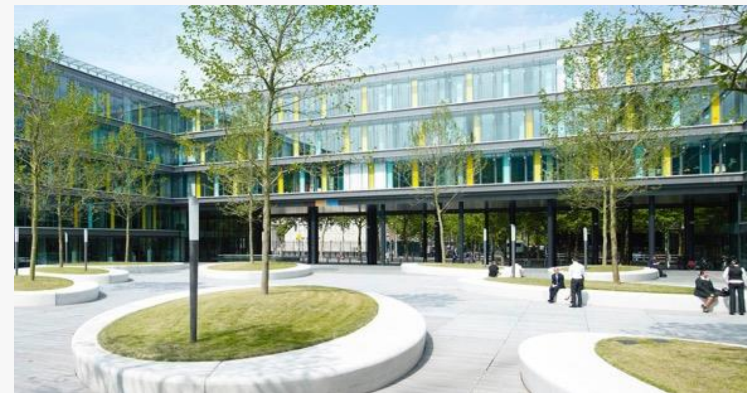
Contractmanagement DBFMO Rijksvastgoedbedrijf
