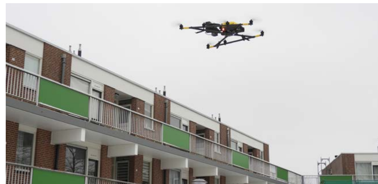
Drone inspectie de Alliantie
