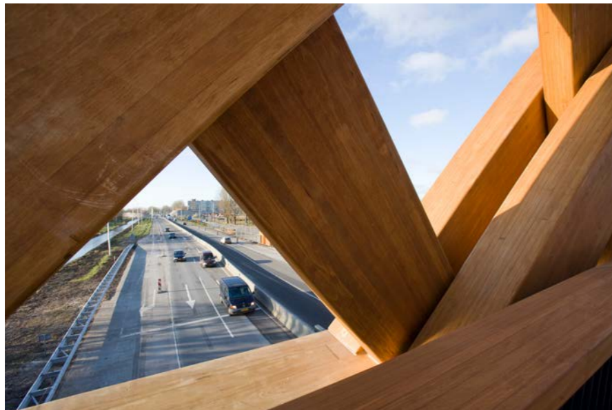
^ Verkeersbrug, Sneek OAK (Onix Achterbosch Kunstwerken) Provincie Fryslân, Rijkswaterstaat Fotograaf: Peter de Kan
