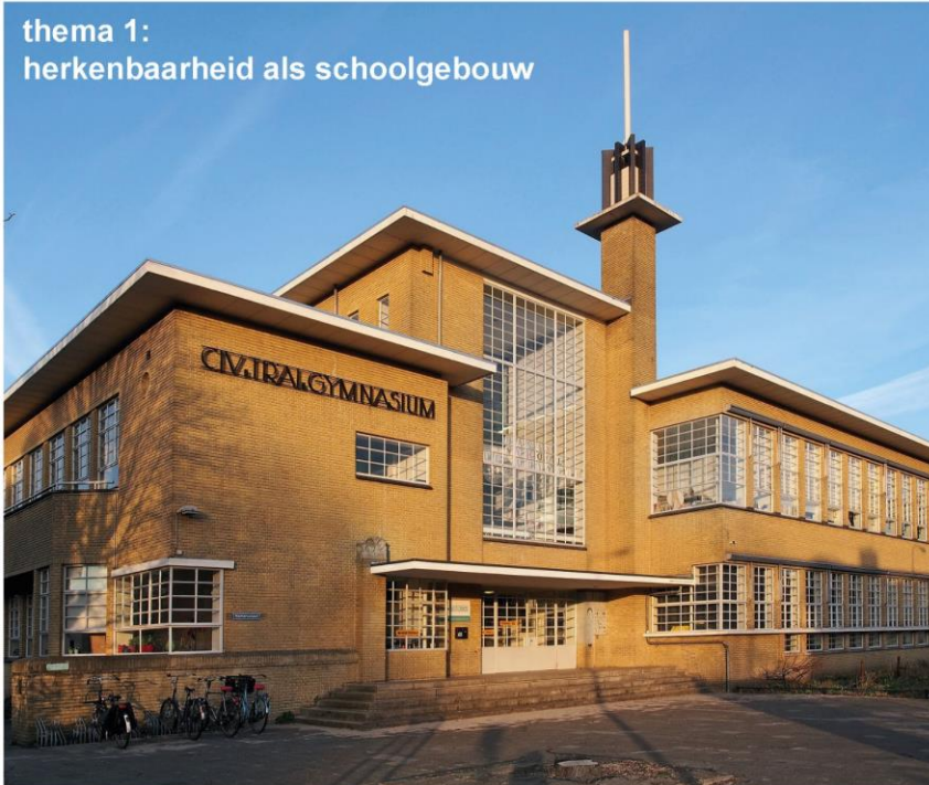
Duidelijk volume, leesbaar als school dankzij raampartijen, torentje, trappen en geleding
