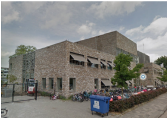
Gebouwd na 2003 Exploitatie/geen ingreep
