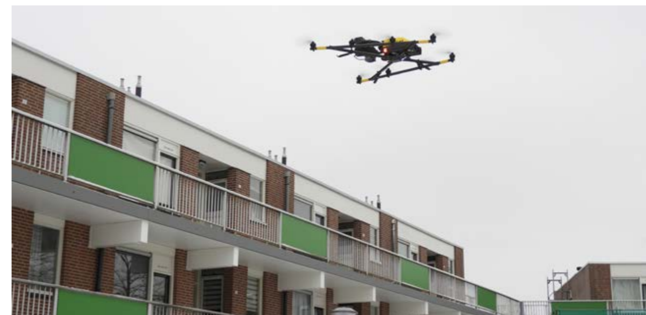
Drone inspectie de Alliantie
