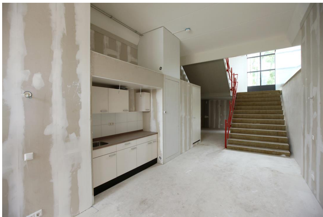
Opleidingscentrum Brinkwal verbouwd tot woningen voor jongeren. Huurders dachten mee met het ontwerp
