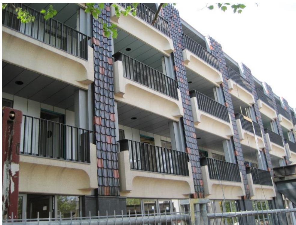
De Hulk, De Alliantie: een van de oudere kantoorpanden in Almere
