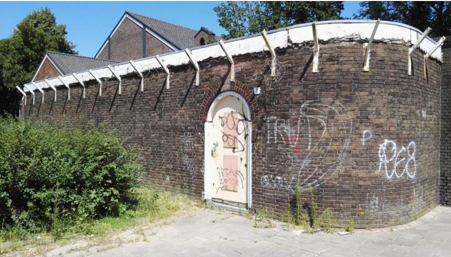
Scoutinggebouw De Nieuwe Augustinus Hergebruik maatschappelijk vastgoed
