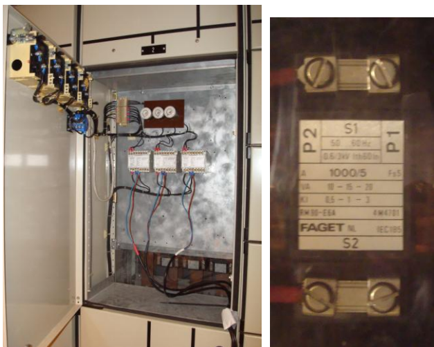
Figuur 3.1. Het aansluitpunt in de dimmeruimte van de Rotterdamse Schouwburg met daarin de stroomtransformatoren welke gebruikt worden voor de stroommeting (Type : Faget Type R90-E6A4M4701 1000A:5A 10,15,20A klasse 0,5)
