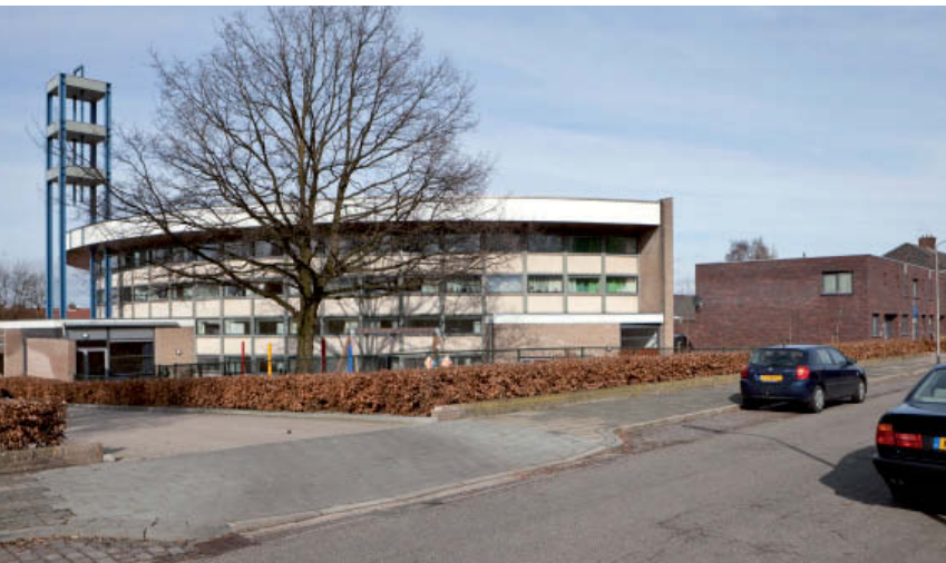
De Daniëlkerk in Nijmegen werd op het nippertje van sloop gered. In deze Wederopbouwkerk zijn nu appartementen voor begeleid wonen, een kinderdagverblijf en een dagbesteding van een school voor moeilijk lerende kinderen ondergebracht. De enorme kerkzaal, gebouwd voor 1000 personen, is daartoe verkleind. Het project werd financieel mogelijk door het realiseren van een aantal nieuwbouwwoningen op het terrein naast de kerk, ter plekke van de voormalige pastorie en sacristie.
