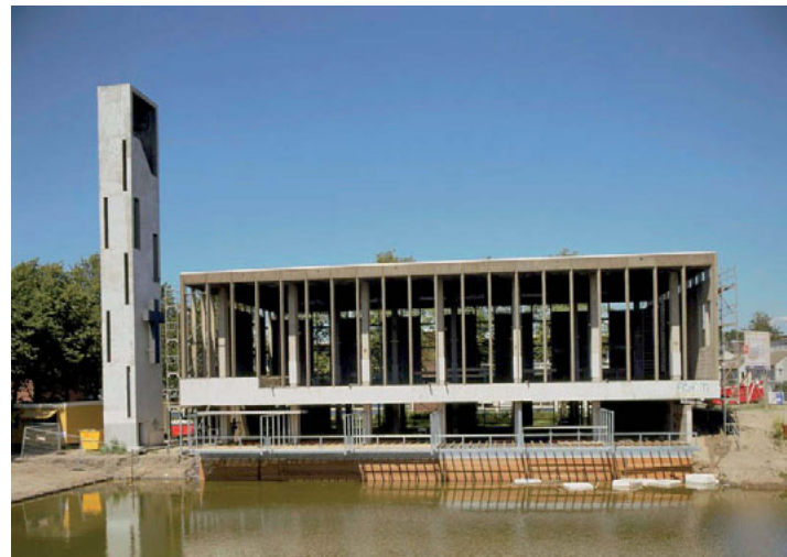
Kerken uit de Wederopbouwperiode lenen zich in het algemeen goed voor nieuwe bestemmingen. De Opstandingskerk in Schiedam tijdens de verbouwing tot woningen.
