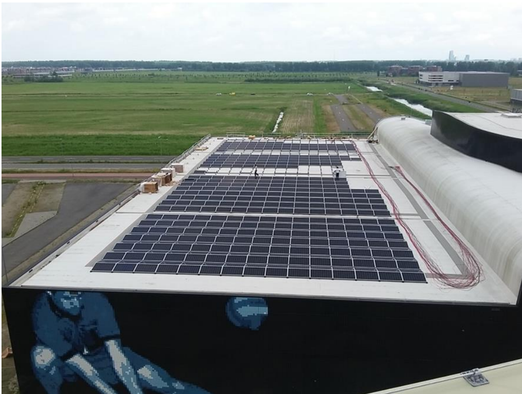
Afbeelding 6: Plaatsing van zonnepanelen op de Topsporthal
