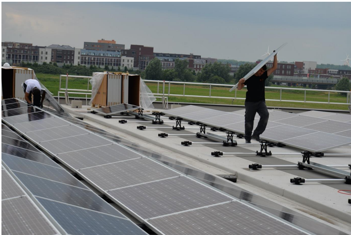
Afbeelding 12: De aanleg van zonnepanelen op het dak van het Indoorsportcomplex Olympiakwartier
