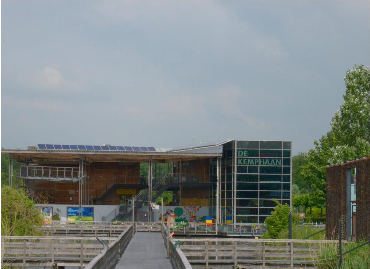
Afbeelding 7: Plaatsing van zonnepanelen op gebouw De Kempphaan
