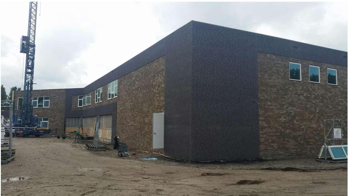
Afbeelding 3: School Aquamarijn in wijk De Laren in aanbouw
