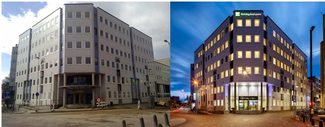
Cito-pand: leegstaand in 2011 (foto links) en na transformatie in 2013 (foto rechts)
