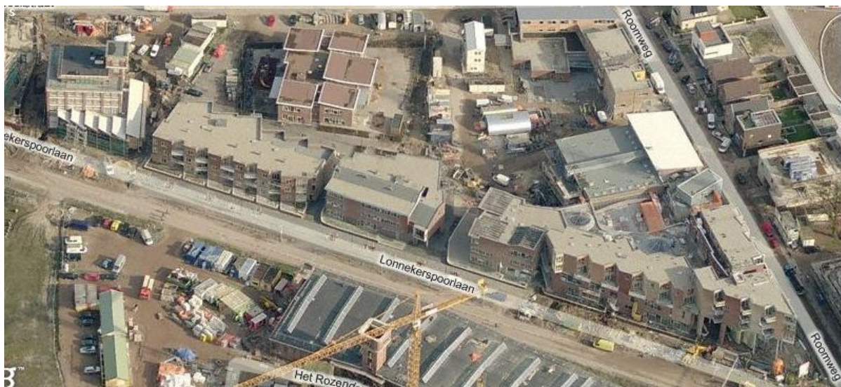
Multifunctionele accommodatie Prismare (hoek Roomweg en Lonnekerspoorlaan, Enschede).
