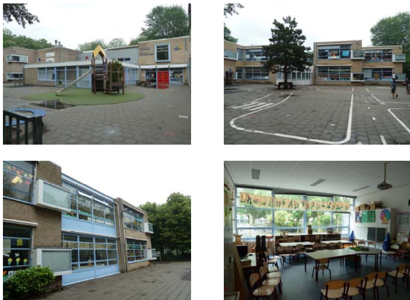
Figuur 7.12 Foto's van het schoolgebouw. Linksboven: Hoofdingang met schoolplein. Rechtsboven: Westgevel. Linksonder: Zuidgevel. Rechtsonder: Klaslokaal
