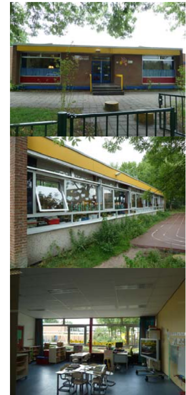
Figuur 7.3Foto van het schoolgebouw
