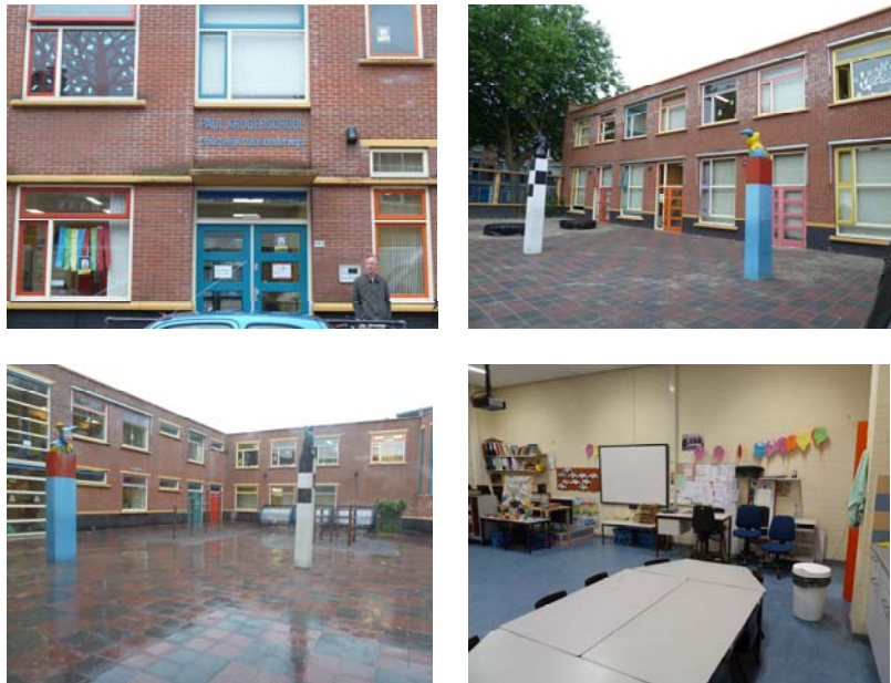
Figuur 7.22 Foto's van de Paul kruger school. Linksboven: Hoofdingang van de school. Rechtsboven: Gevel aan de binnenplaats (west-gevel). Linksonder: Gevels aan de binnenplaats(oostgevel). Rechtsonder: klaslokaal.
