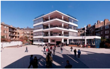
Figuur 18: Openluchtschool J. Duiker (1929-1930) https://gidsy.com/activities/amsterdam/6882/visit-duikers-1930-openluchtschool/
