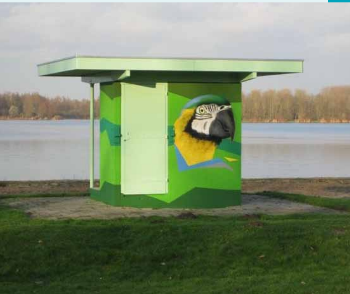
Sanitaire voorziening op strand, door onderhoud meer kleur en herkenning.
