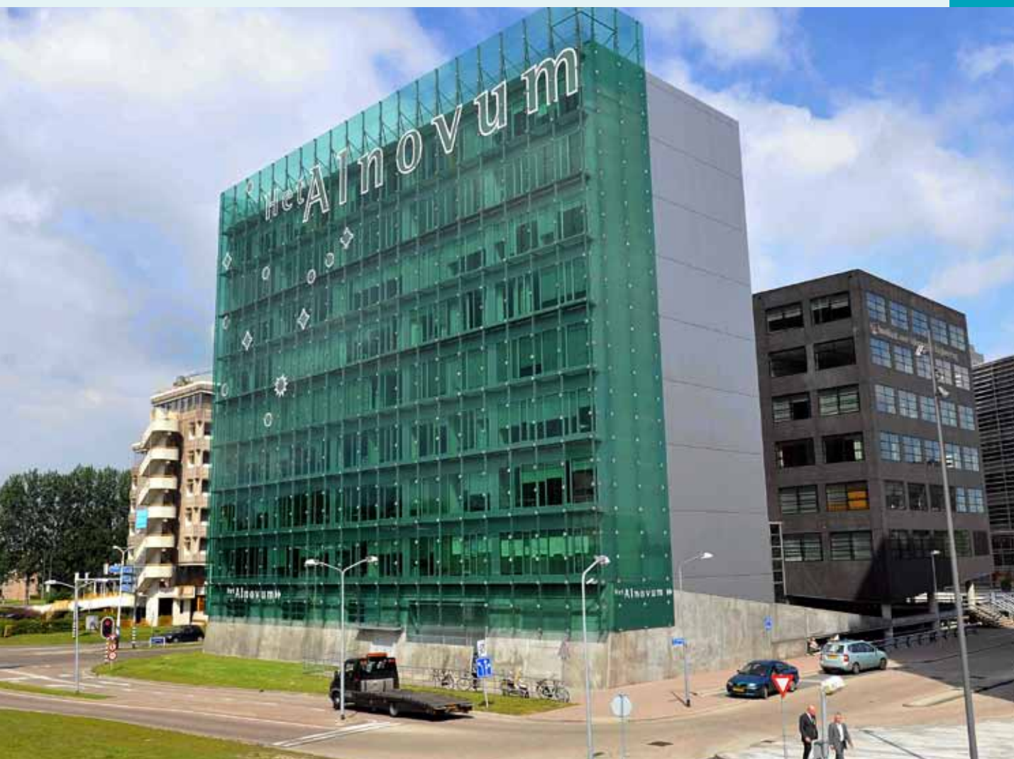
Alnovum, transformatie van kantoor naar hotel.
