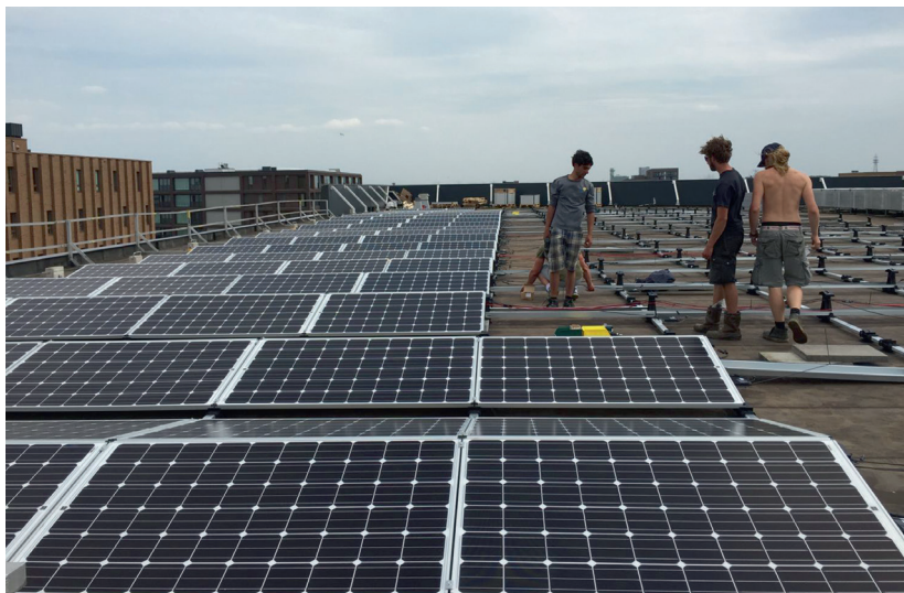
Het IJburg College heeft door middel van crowdfunding zonnepanelen op de daken van de scholen gekregen.
