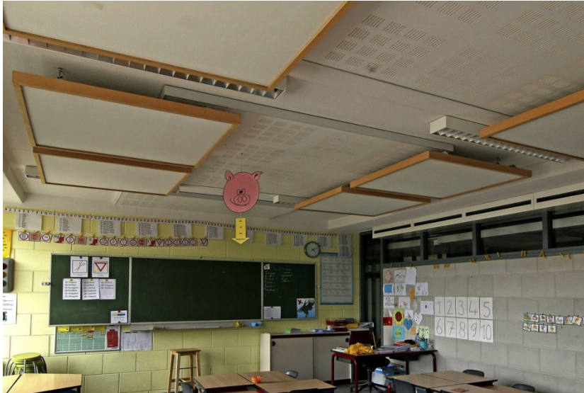
Foto 1: Dit leslokaal voldeed aan het toenmalige bouwbesluit waarin een nagalmtijd van 1.0 s was vastgelegd. Er is gebruik gemaakt van geperforeerde gipsplaten met glaswol aan de achterzijde; zie de panelen met de aluminium rand. De hoeveelheid absorptie bedekte lang niet het gehele plafond, maar dat was ook niet nodig om de eis van het bouwbesluit te halen. Maar omdat die eis niet deugde ontstonden klachten van de leerkrachten. Daarna is extra absorptie toegevoegd (de panelen met een houten rand) [10].
