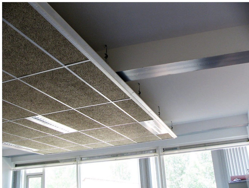
Foto 4: In sommige schoollokalen wordt het plafond ook benut voor verwarming en/of koeling. Een gesloten systeemplafond is dan onmogelijk. Nog steeds is een hoeveelheid absorptie ter grootte van het plafond het startpunt van het ontwerp, maar de geluidabsorptie zal dan op de wanden moeten worden aangebracht.
